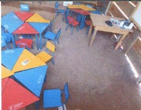
Foto1: MODULO DE AULAS - mejoramiento piso
