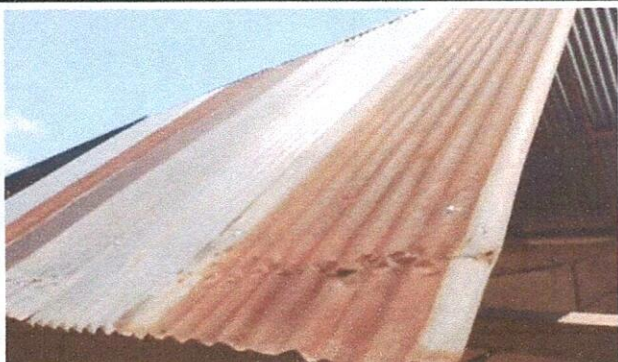
Foto 3: MODULO DE AULAS - Mejoramiento de estructura de techo
